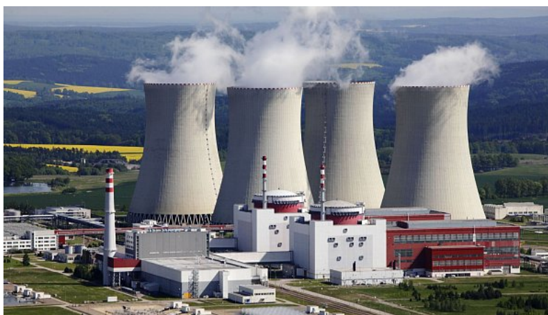
Chladící věže jaderné elektrárny Temelín
